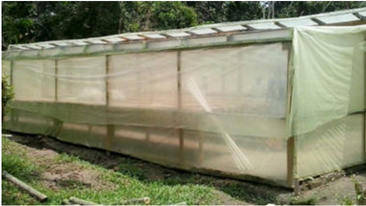
Ilustración 42. Drenaje perimetral de invernadero
