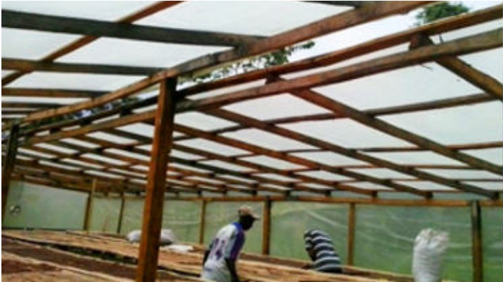
Ilustración 49. Invernadero de madera con cubierta de plástico
